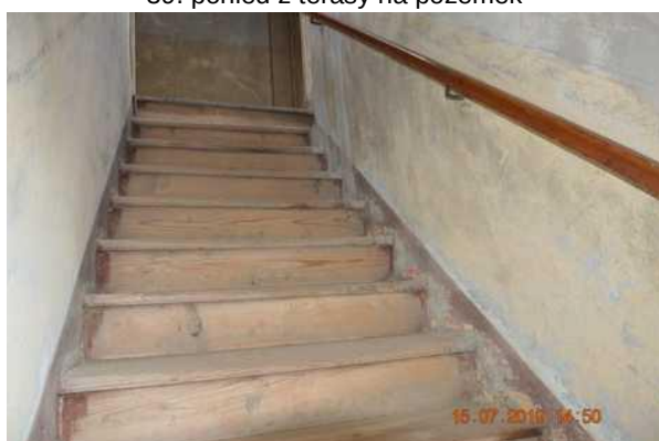
41. schodiště 2.NP - podkroví
