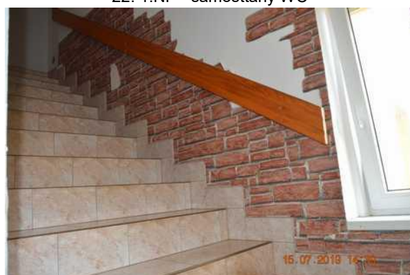
24. schodiště 1NP. - 2.NP
